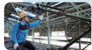
作業予定の確認と危険予測
