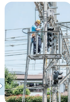
2 9:15 信号機の点検。正常に通電しているか確認します。
